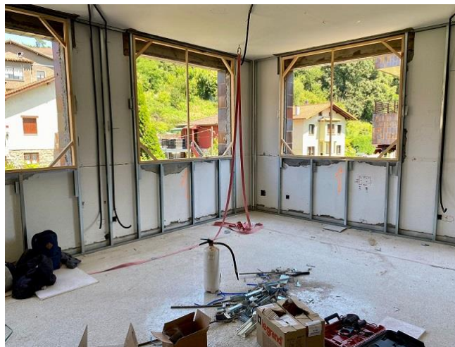
Obras del centro de día para personas con discapacidad intelectual
